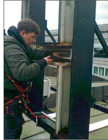
Tobias Schlottag baut die alten Neonsysteme aus und rüstet um auf LEDs.
